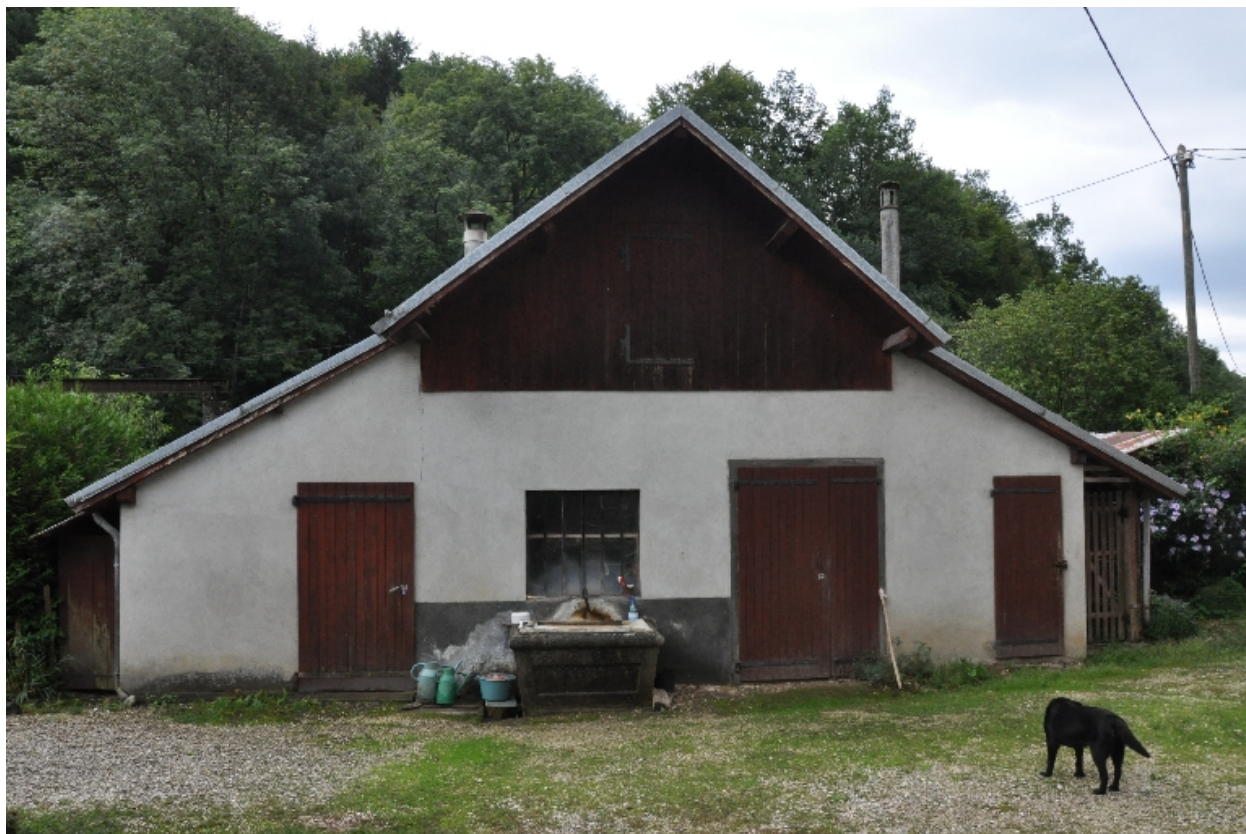
Vue de l'atelier, façade ouest
