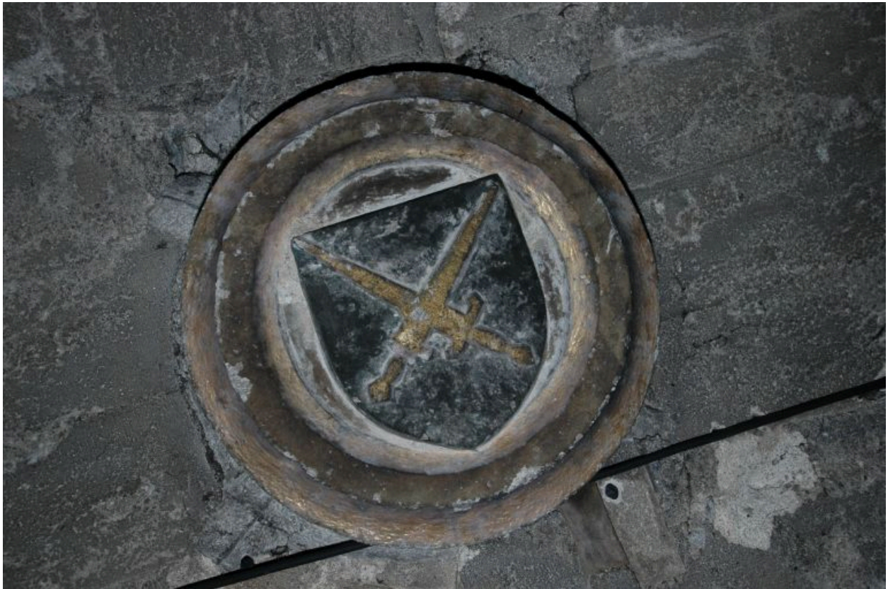
Clé de voûte dans l'étage de soubassement ornée d'armoiries meublées des 2 épées croisées de saint Paul
