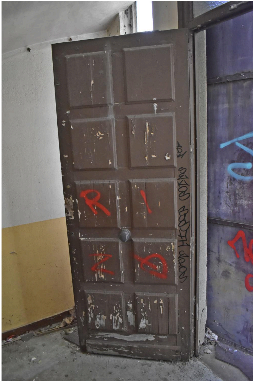
Logement de fonction : porte palière d'entrée d'origine. [Photo chercheur.]
