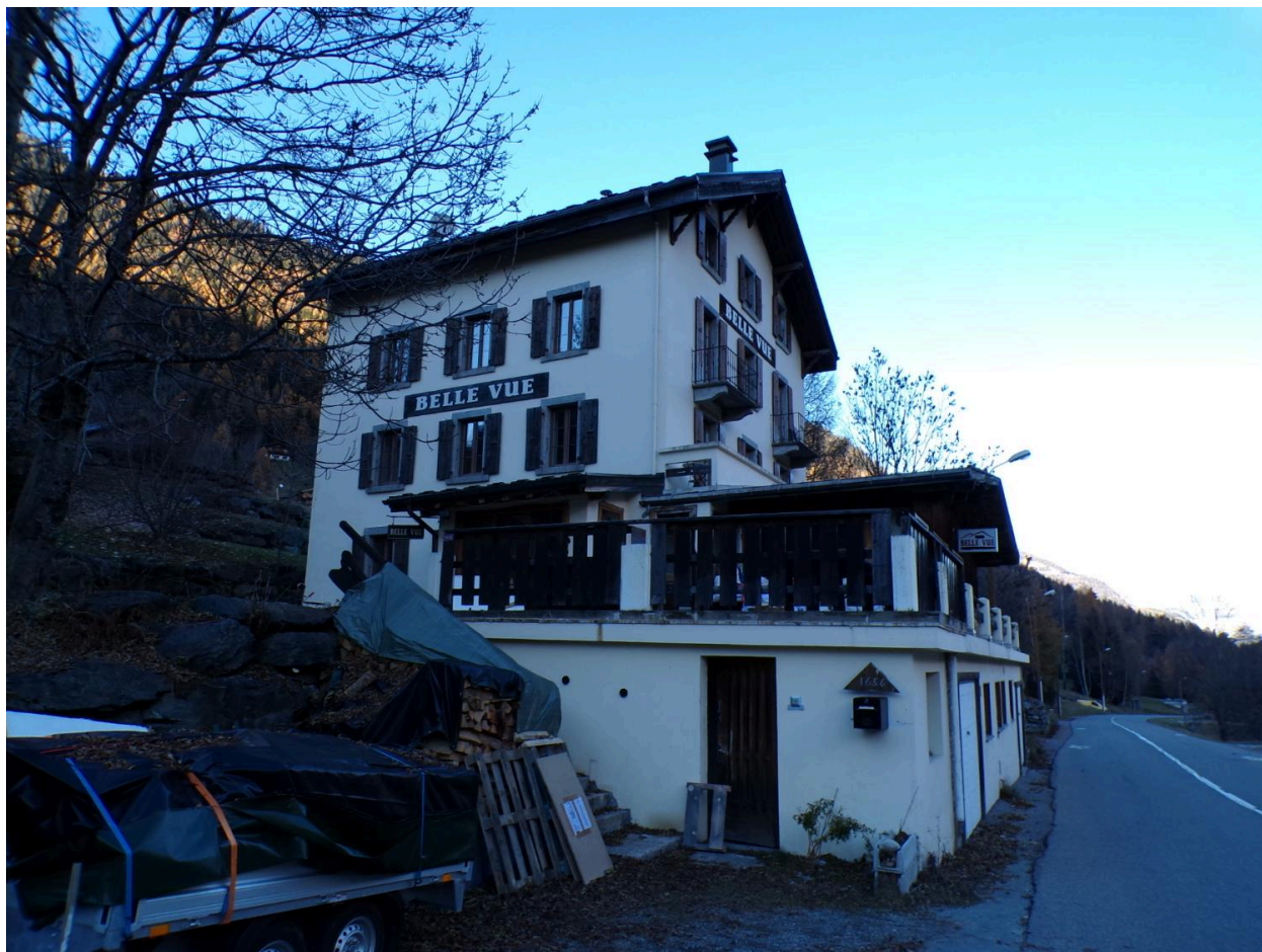
vue de la façade sud
