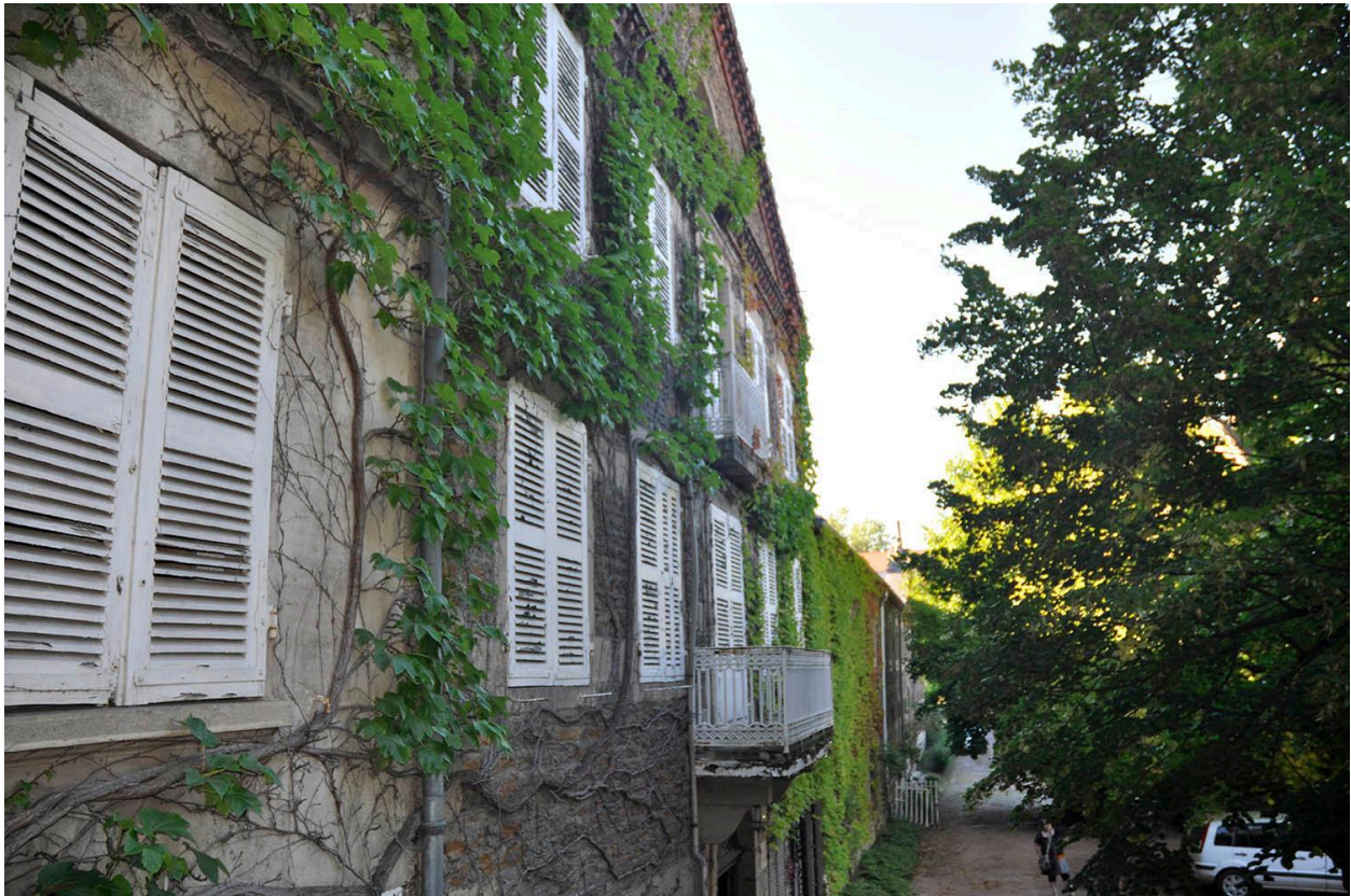
Vue du pavillon d'habitation
