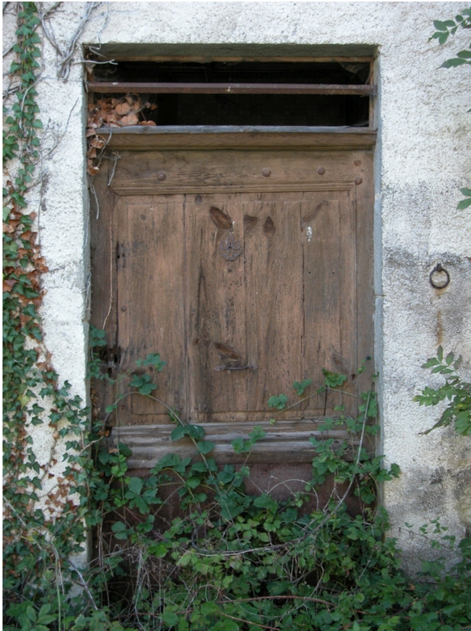
Détail de la porte d'entrée côté chemin.
