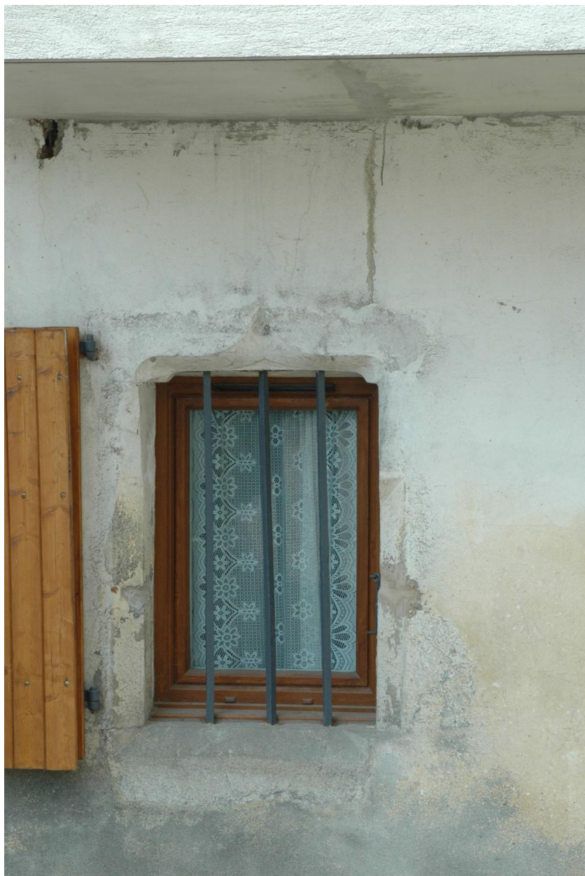
Détail de fenêtre à linteau en arc infléchi (2018 B 315).
