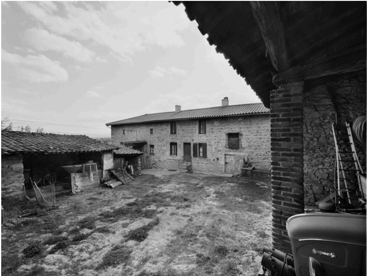
Vue d'ensemble du bâtiment sud, depuis la cour.
