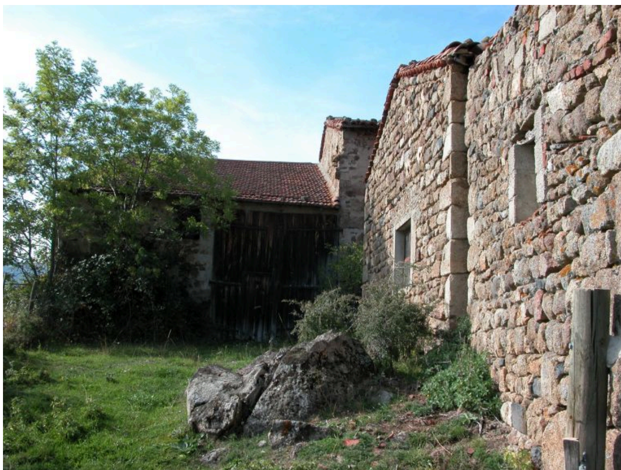
Elévation ouest des communs de la ferme, parcelle 82.
