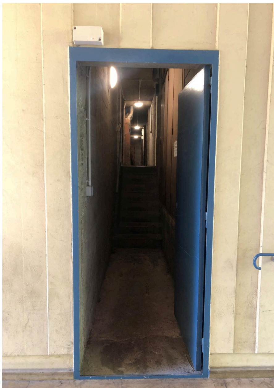
Accès aux caves au sous-sol de l'immeuble
