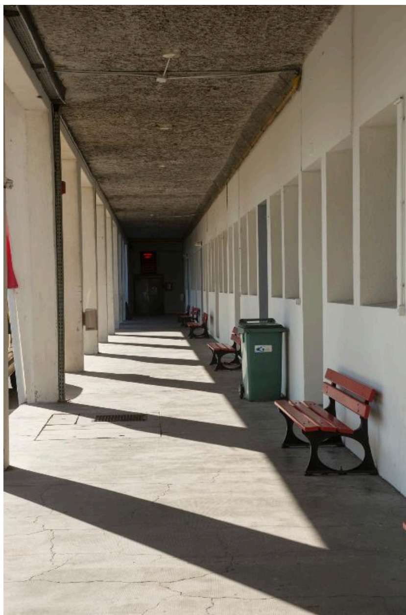
Bâtiment B : galerie du rez-de-chaussée
