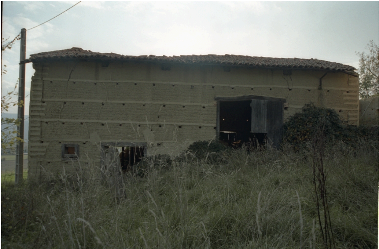
Vue d'ensemble de la grange-étable.
