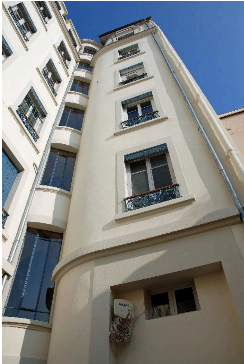
Vue partielle des élévations sur cour
