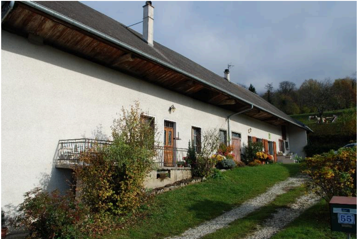
Résine (la), ferme 2014 B3 386 à 388. Vue d'ensemble de trois-quarts avant gauche.
