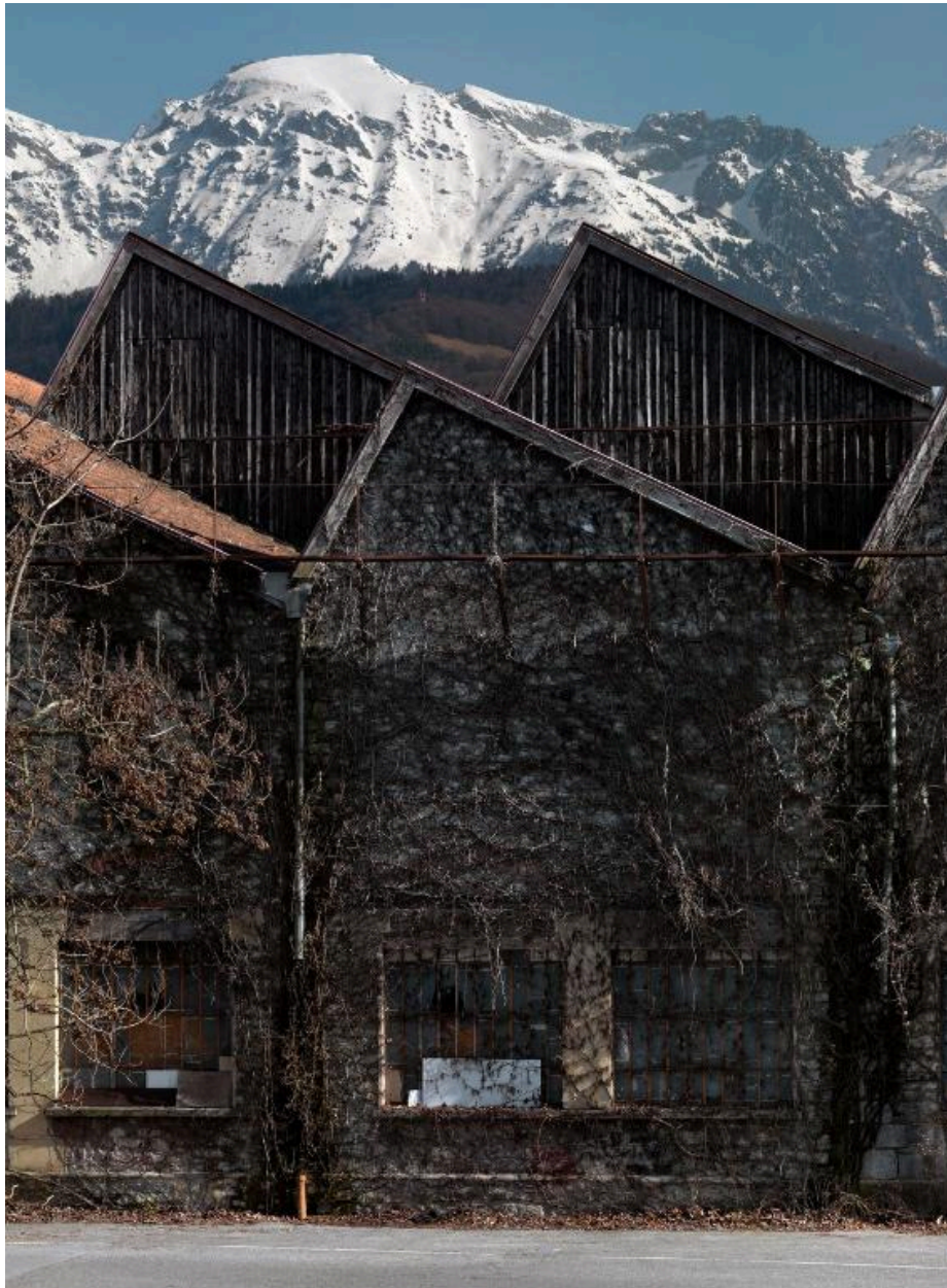
Détail façade atelier
