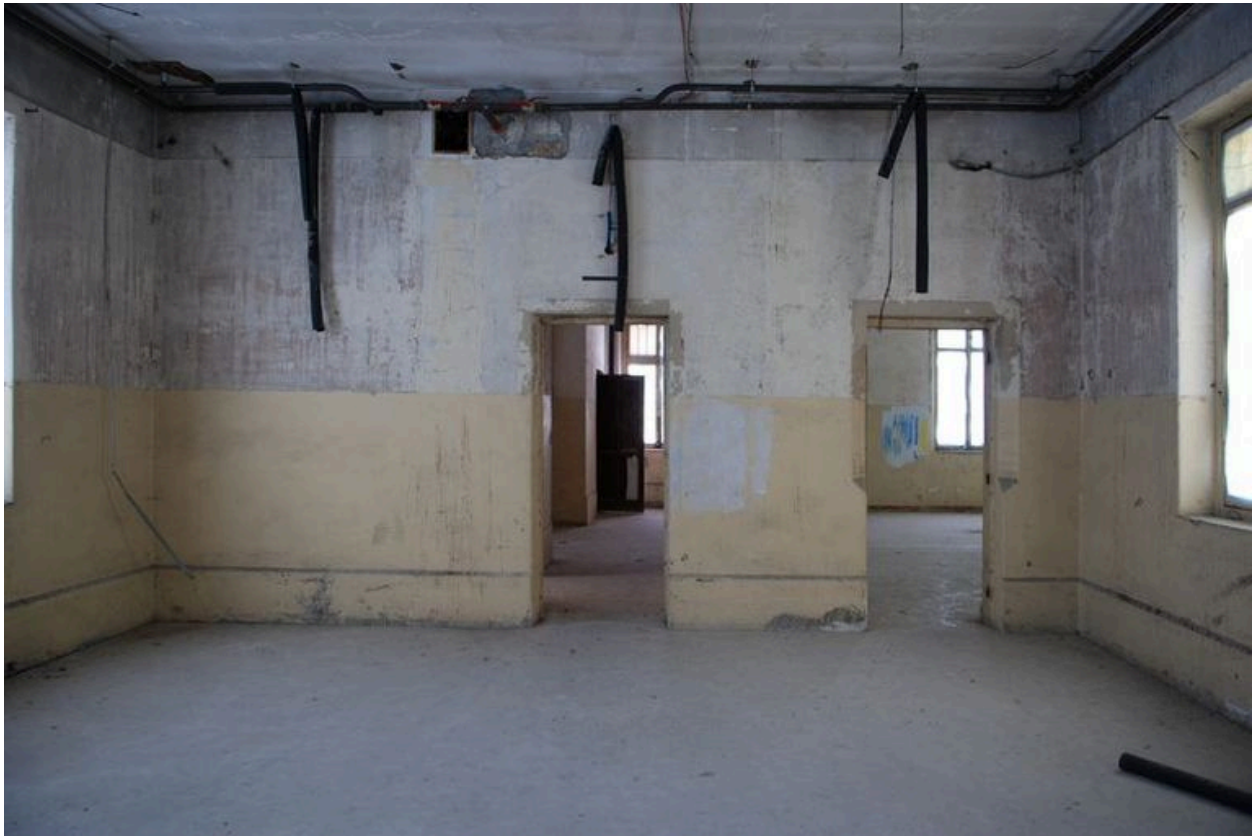
Second étage, salles désaffectées
