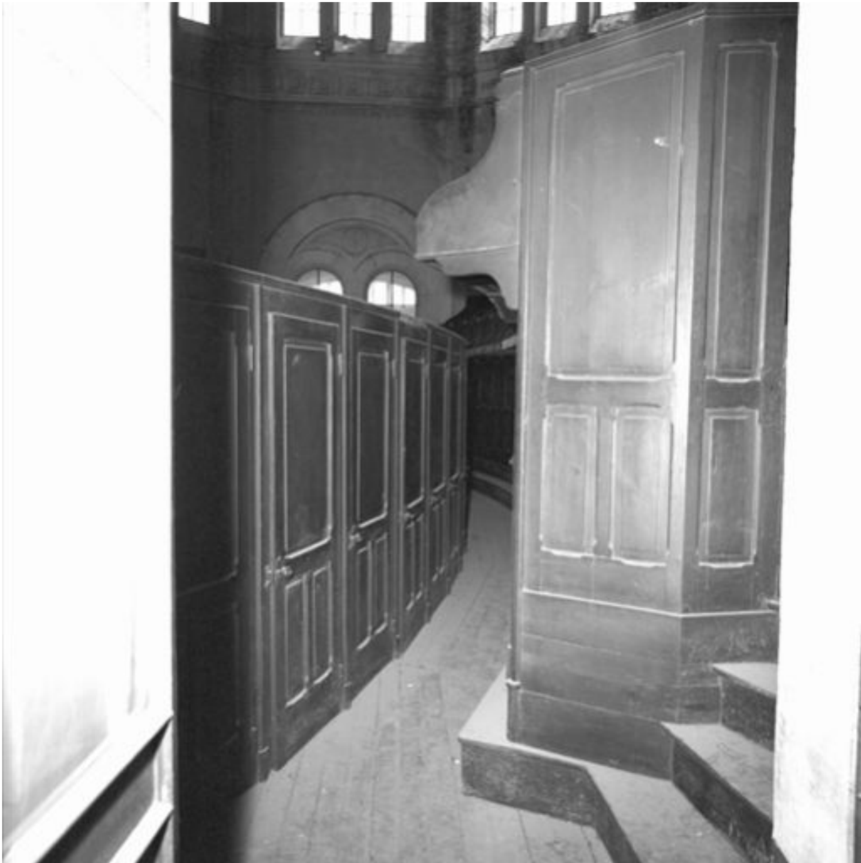
Chapelle : une allée desservant les cases, état en 1984
