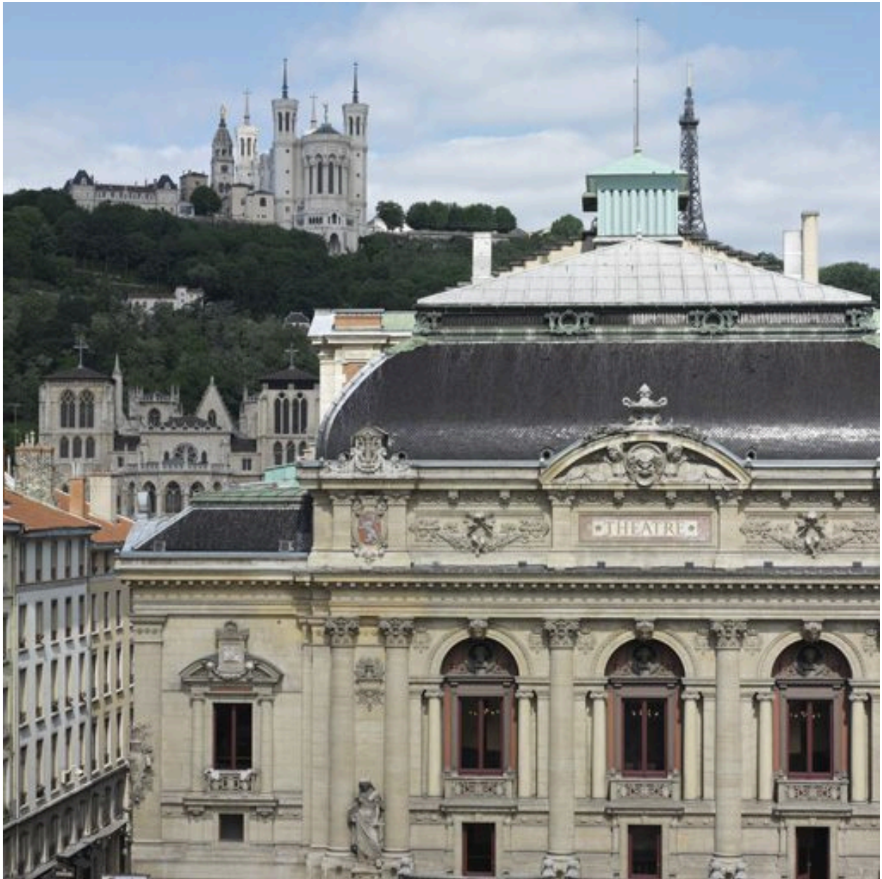
Vue de situation de la toiture
