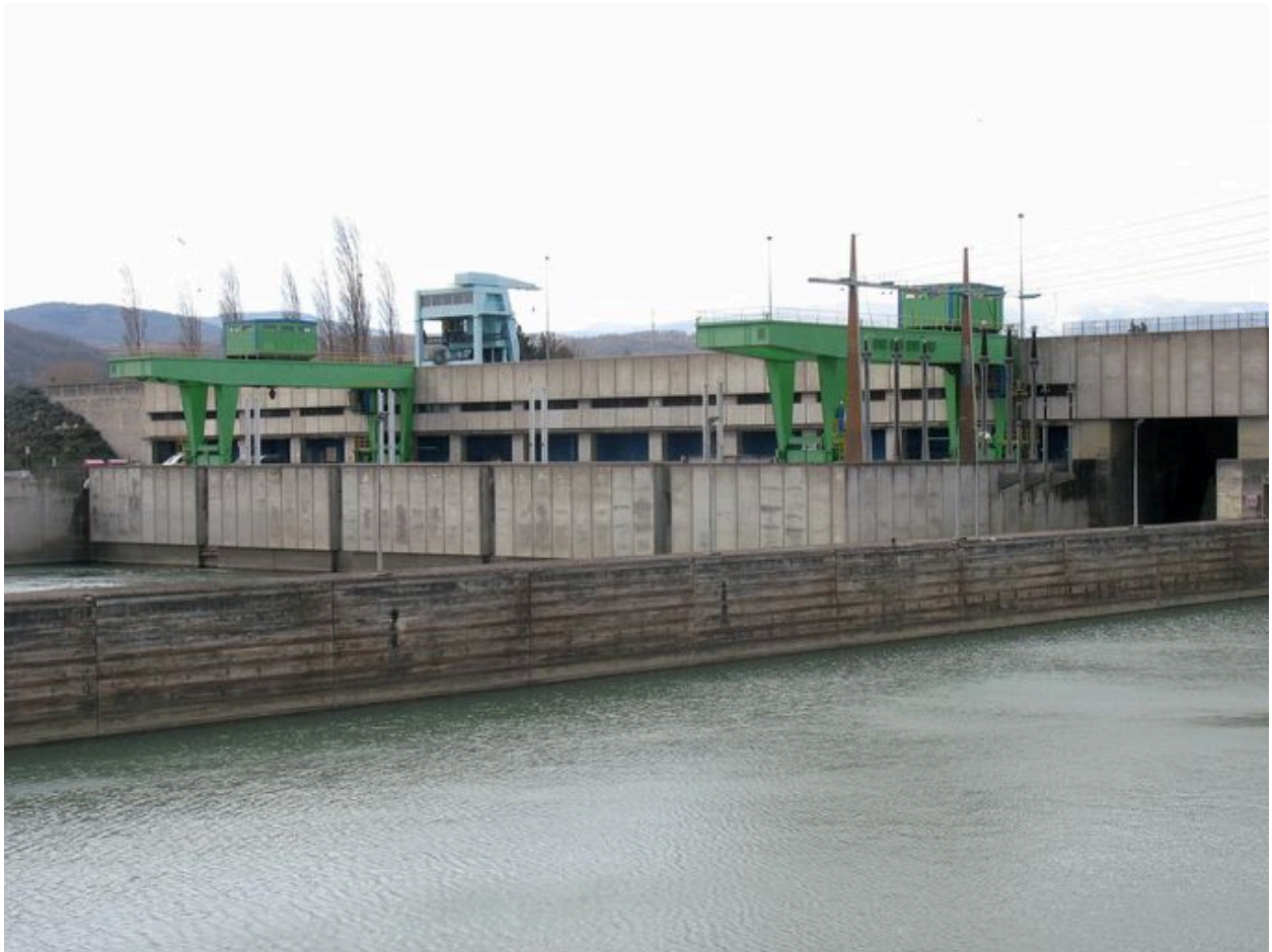
Vue partielle, côté aval (depuis la rive gauche)
