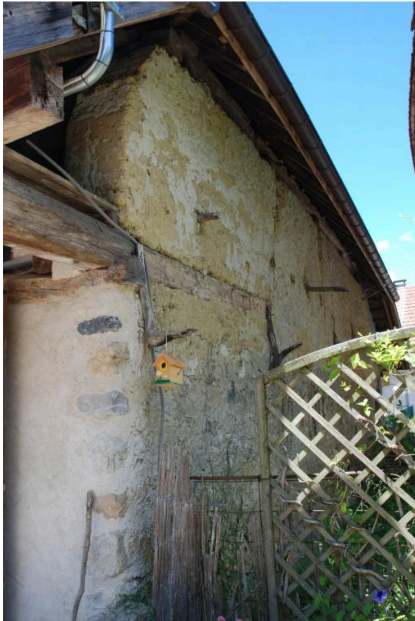
Vue du mur pignon oriental en pisé.
