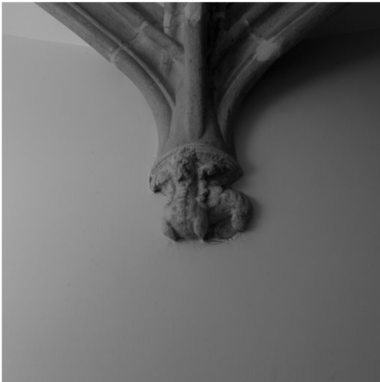
Voûte de l'allée, détail du culot 4
