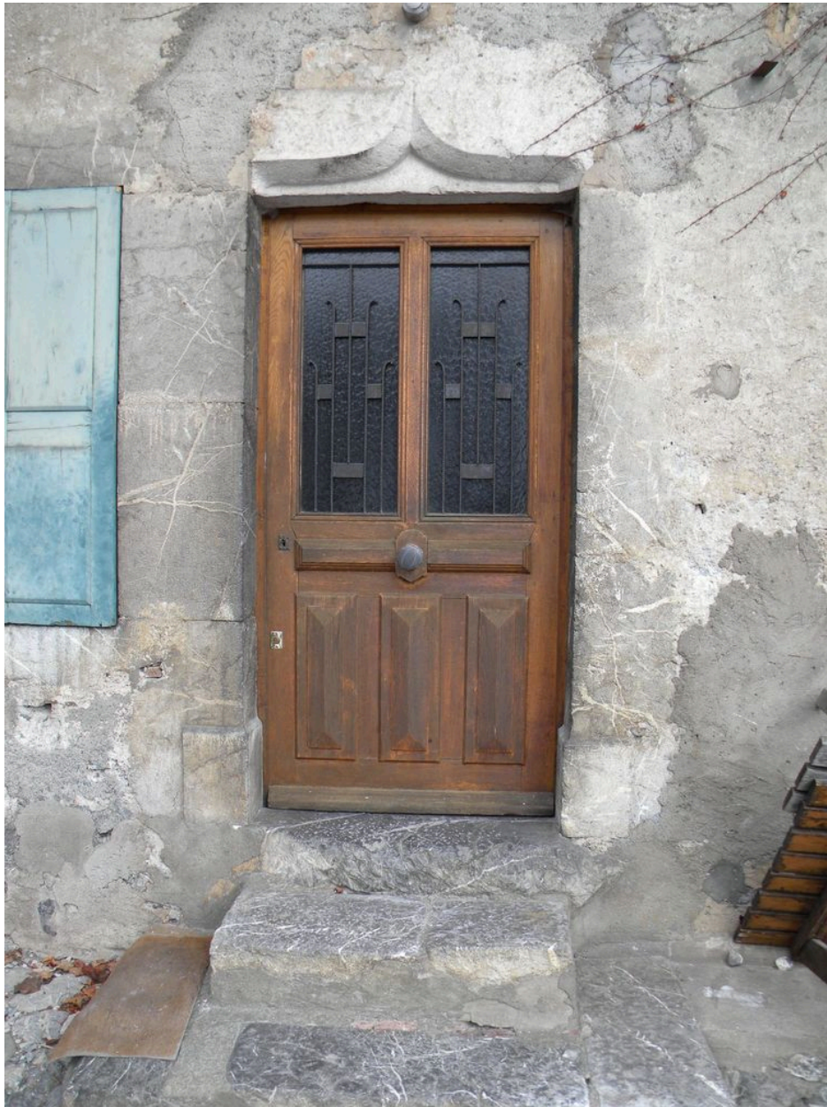
Porte d'entrée avec linteau en accolade de réemploi.
