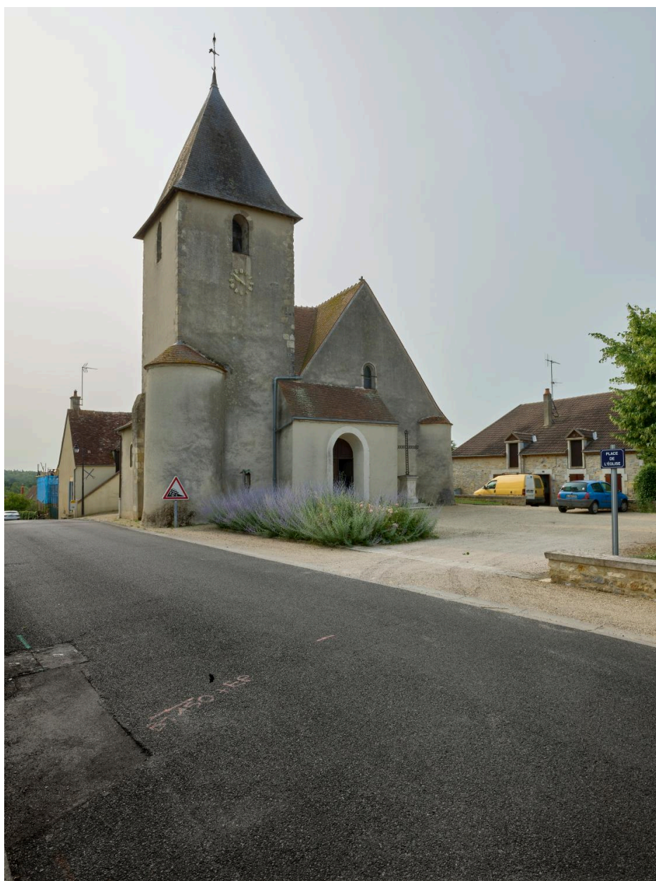
Vue de la façade occidentale de l'église.
