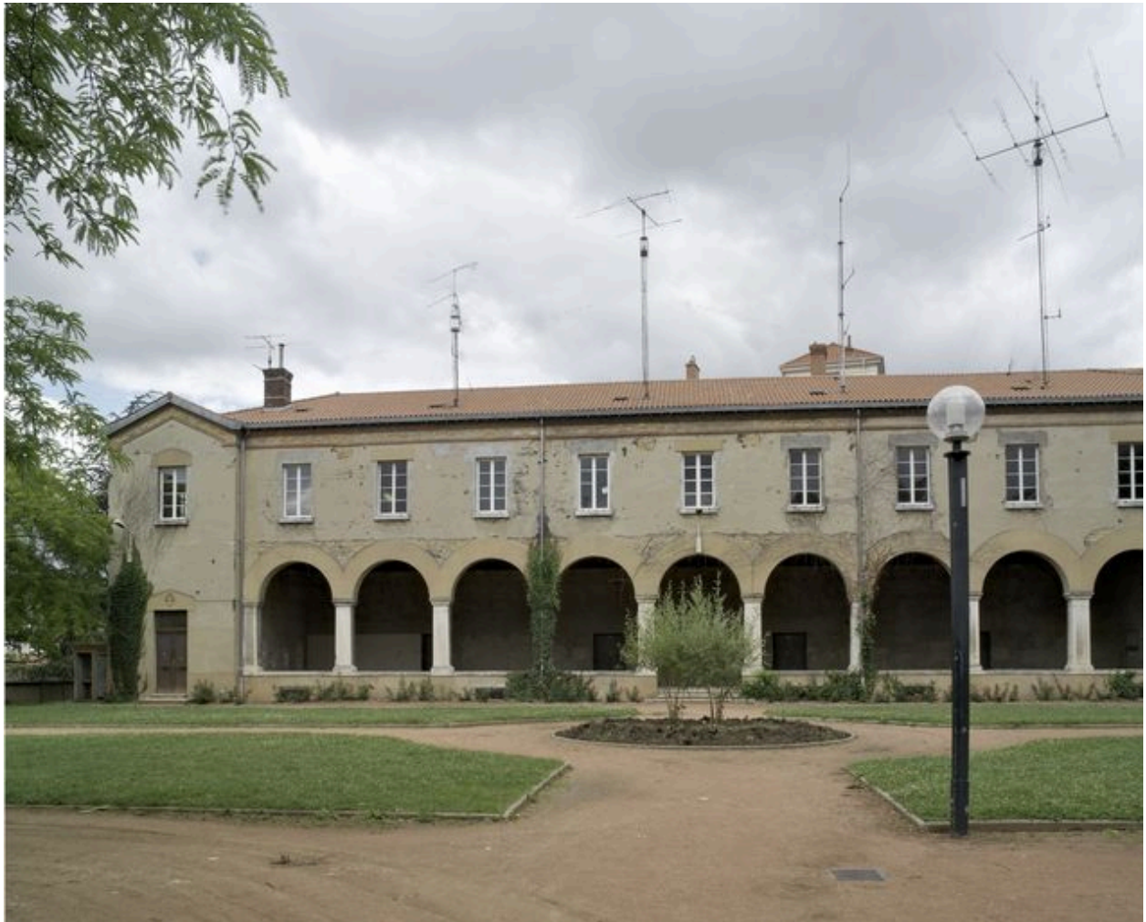
Bâtiment de la galerie, élévation principale, partie sud-ouest
