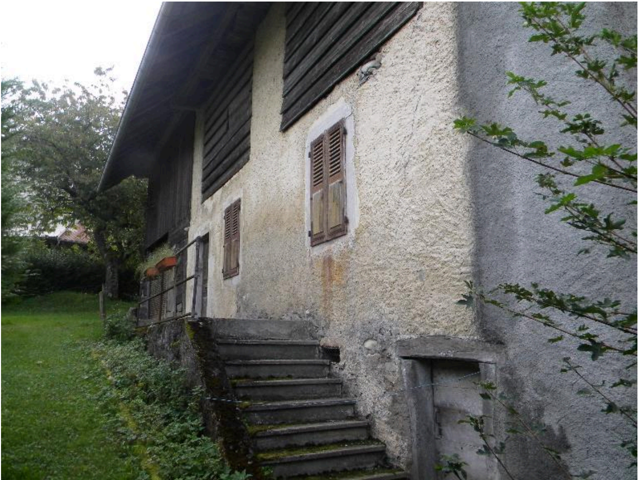
Vue de la façade de l'habitation coté nord.
