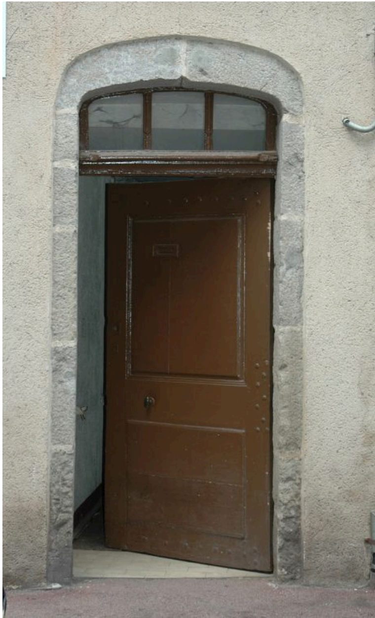
Porte piétonne avec arc en anse de panier.
