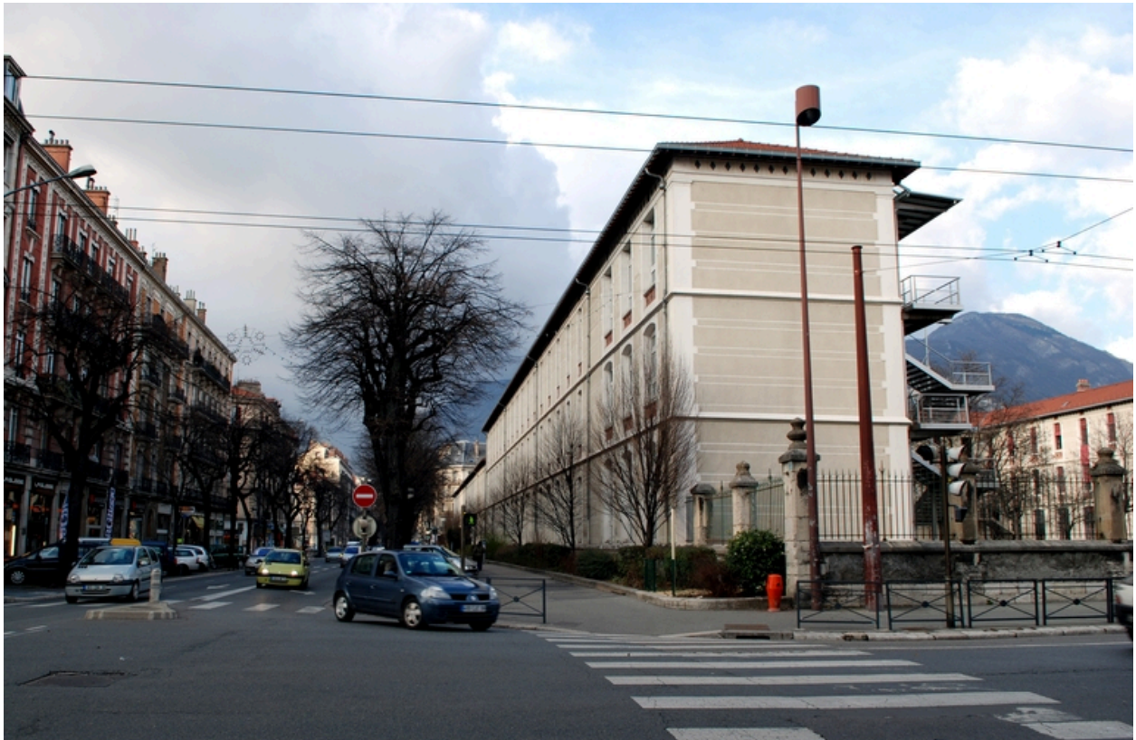
Façade cours Gambetta, vue d'ensemble depuis le sud
