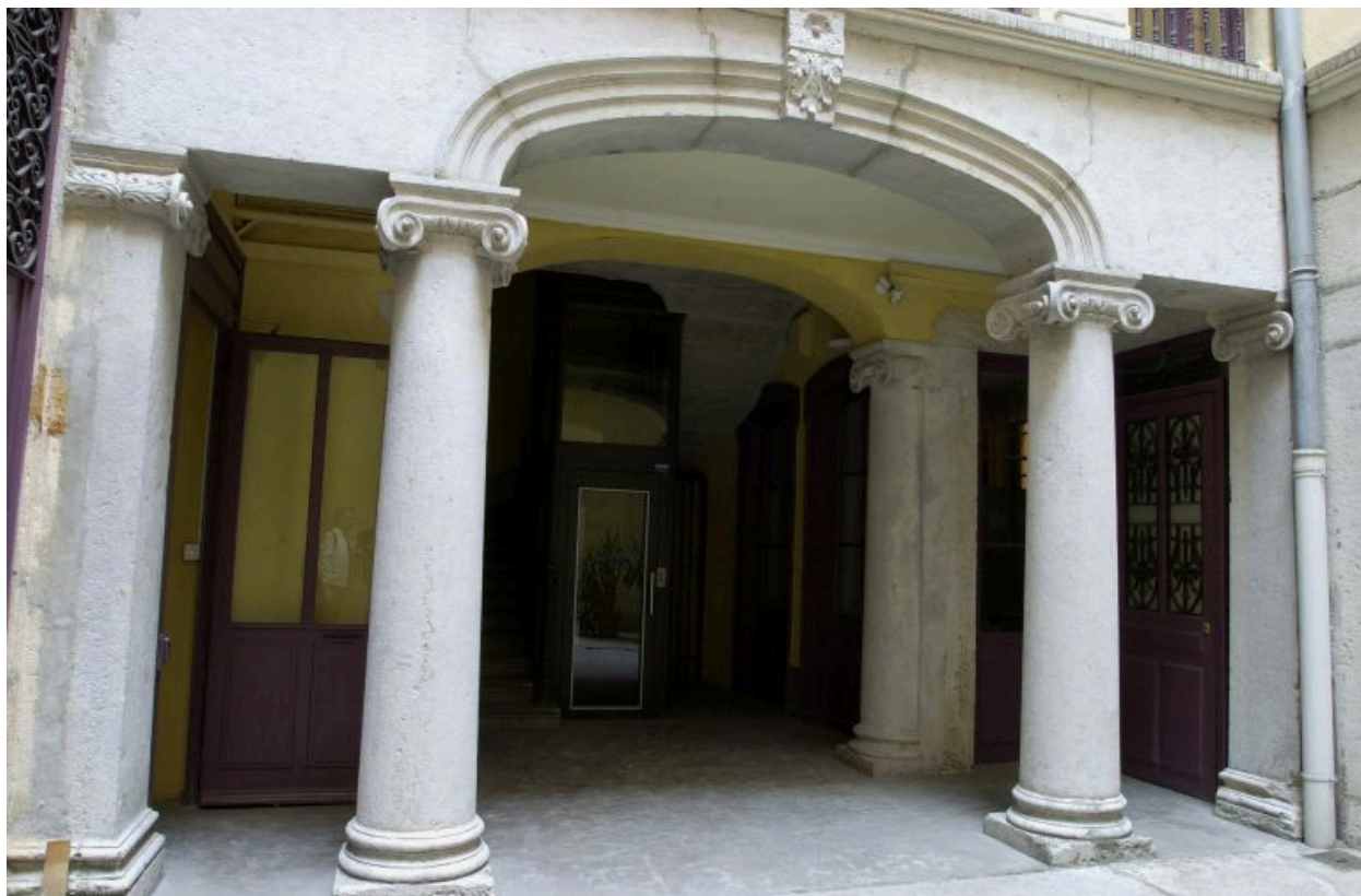
Corps de l'escalier, rez-de-chaussée
