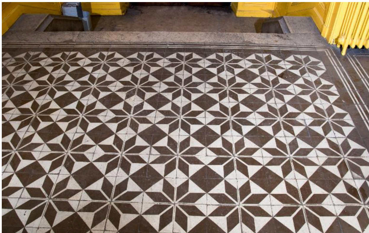
Vestibule d'entrée : sol en carreaux de ciment
