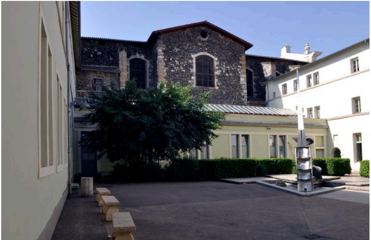
Cour 1 : vue d'ensemble depuis le nord-est
