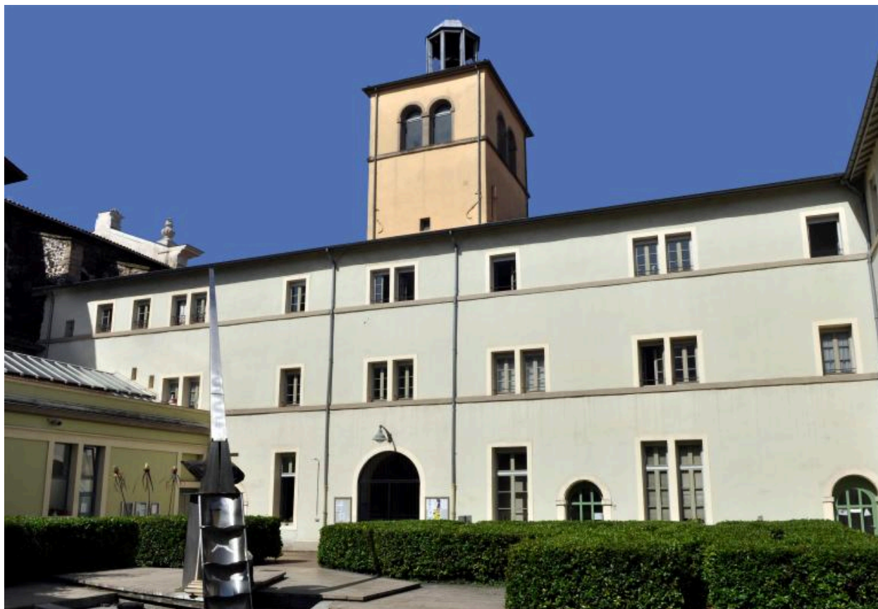
Bâtiment A : élévation sur cour 1
