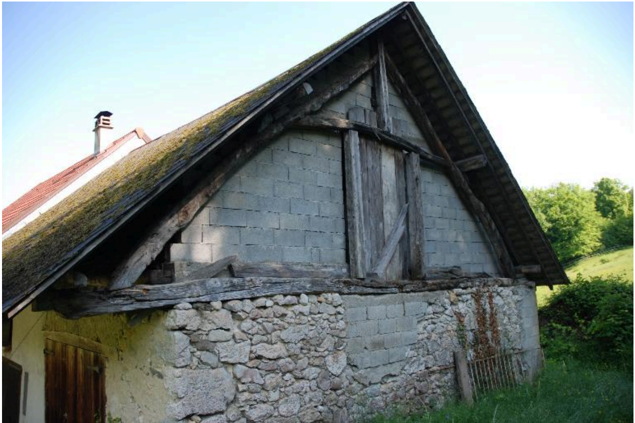
Vue du mur pignon nord-est.
