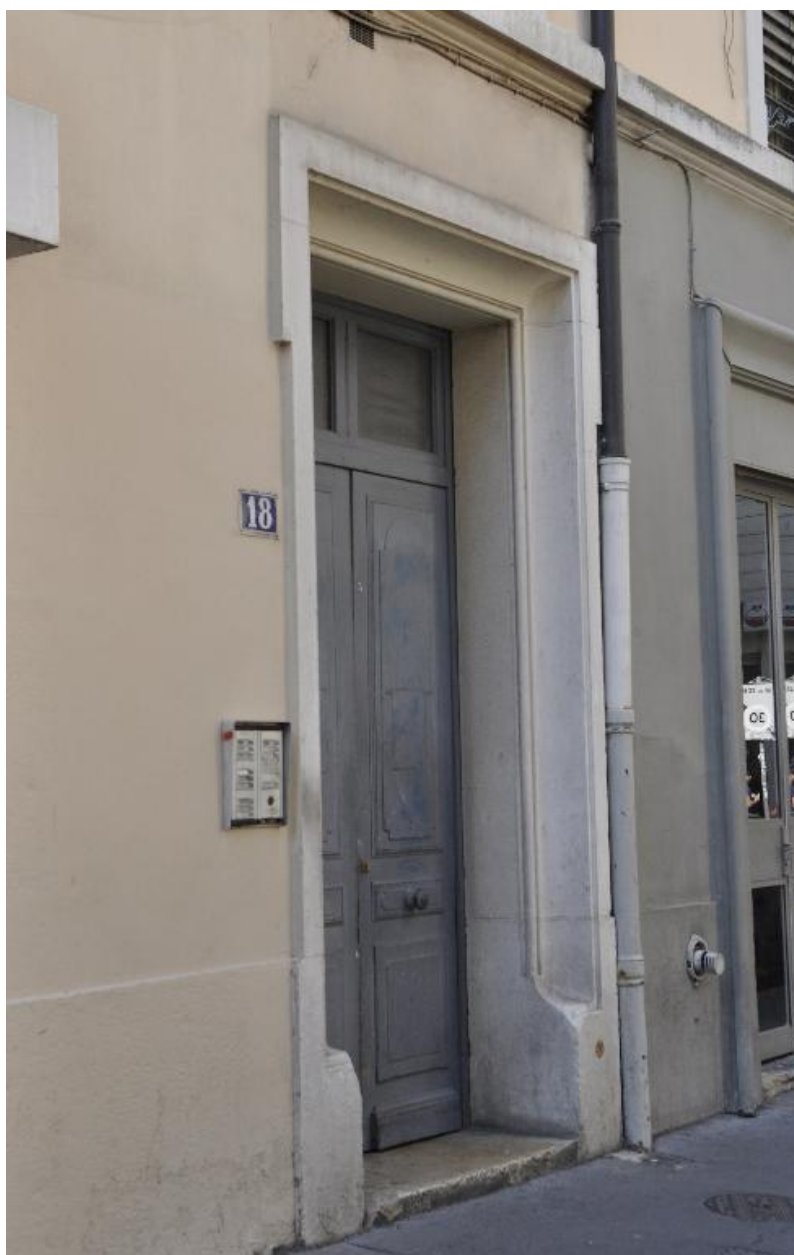
Vue rapprochée de la porte d'entrée
