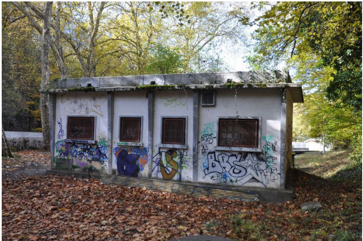
Façade postérieure de la première micro-centrale hydroélectrique de la Curiale
