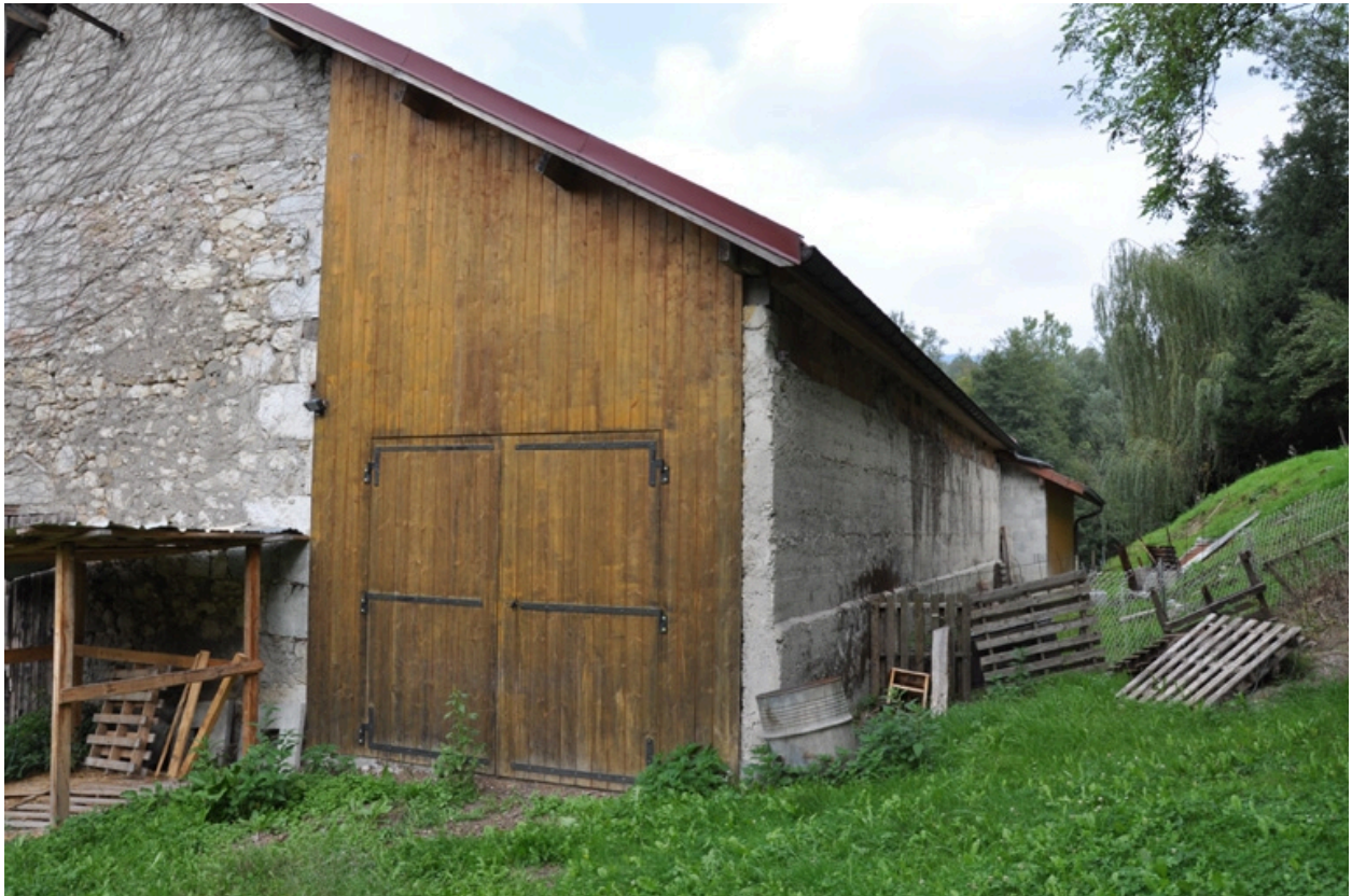
Vue des façades ouest et sud
