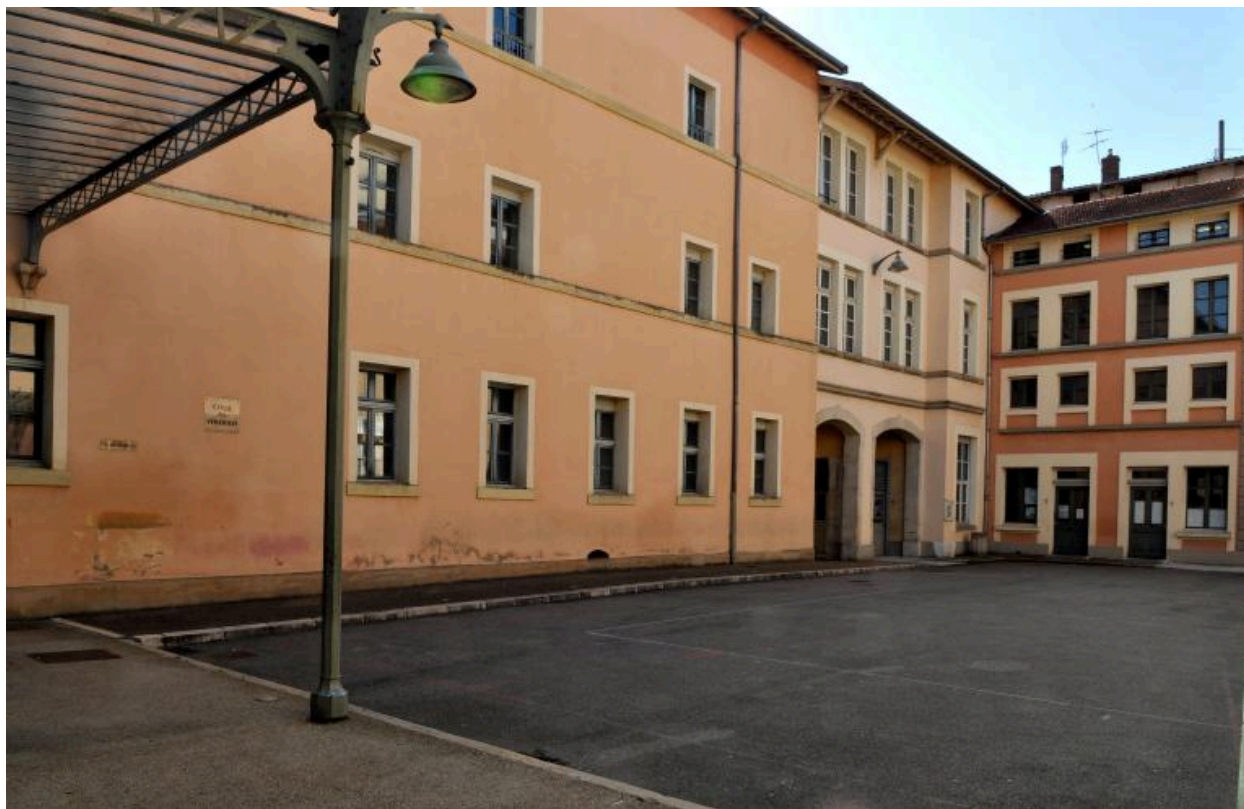
Bâtiment E, élévation sur cour 2 depuis le nord-ouest
