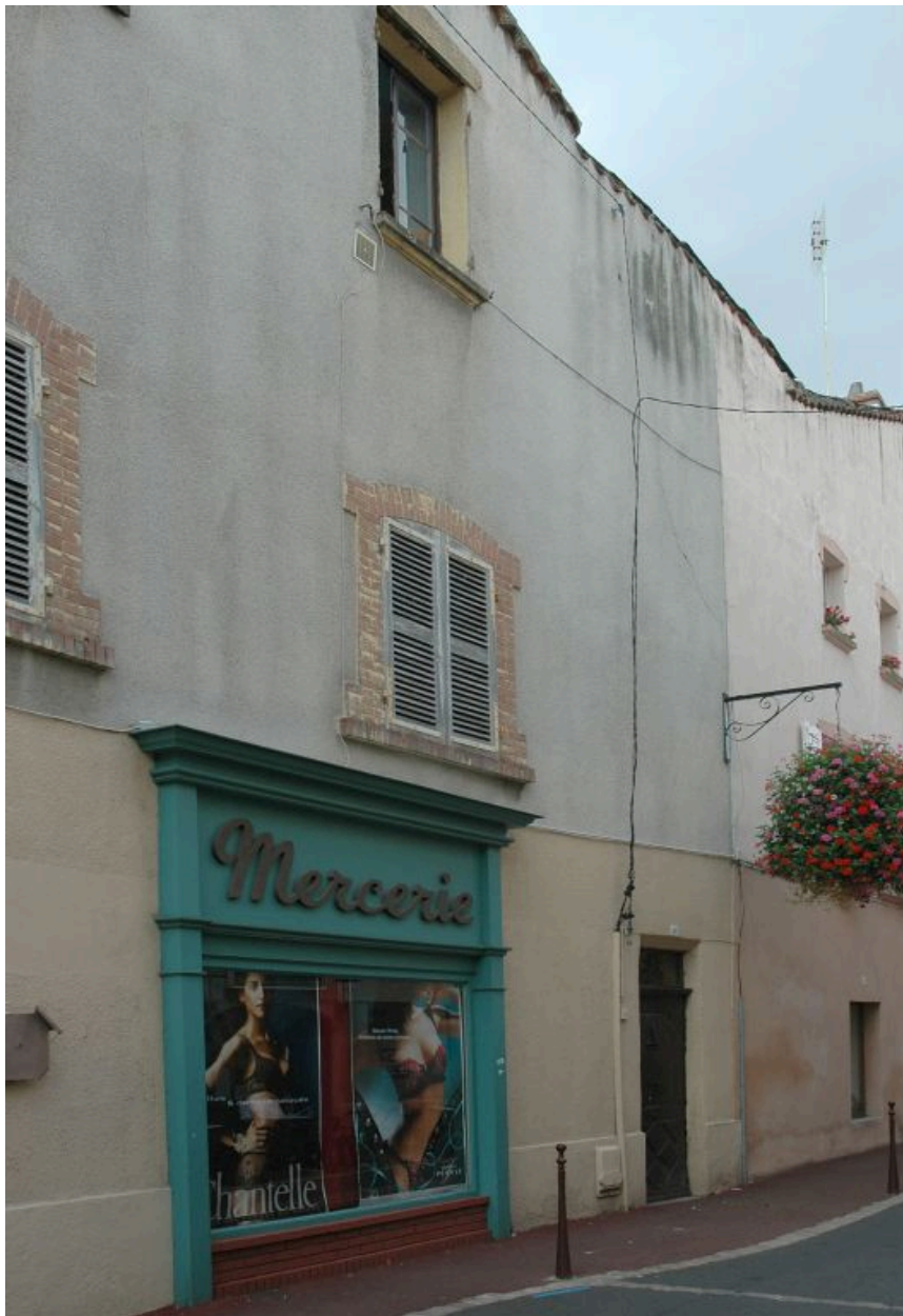
Vue partielle de l'élévation latérale, porte piétonne donnant sur l'ancienne venelle.
