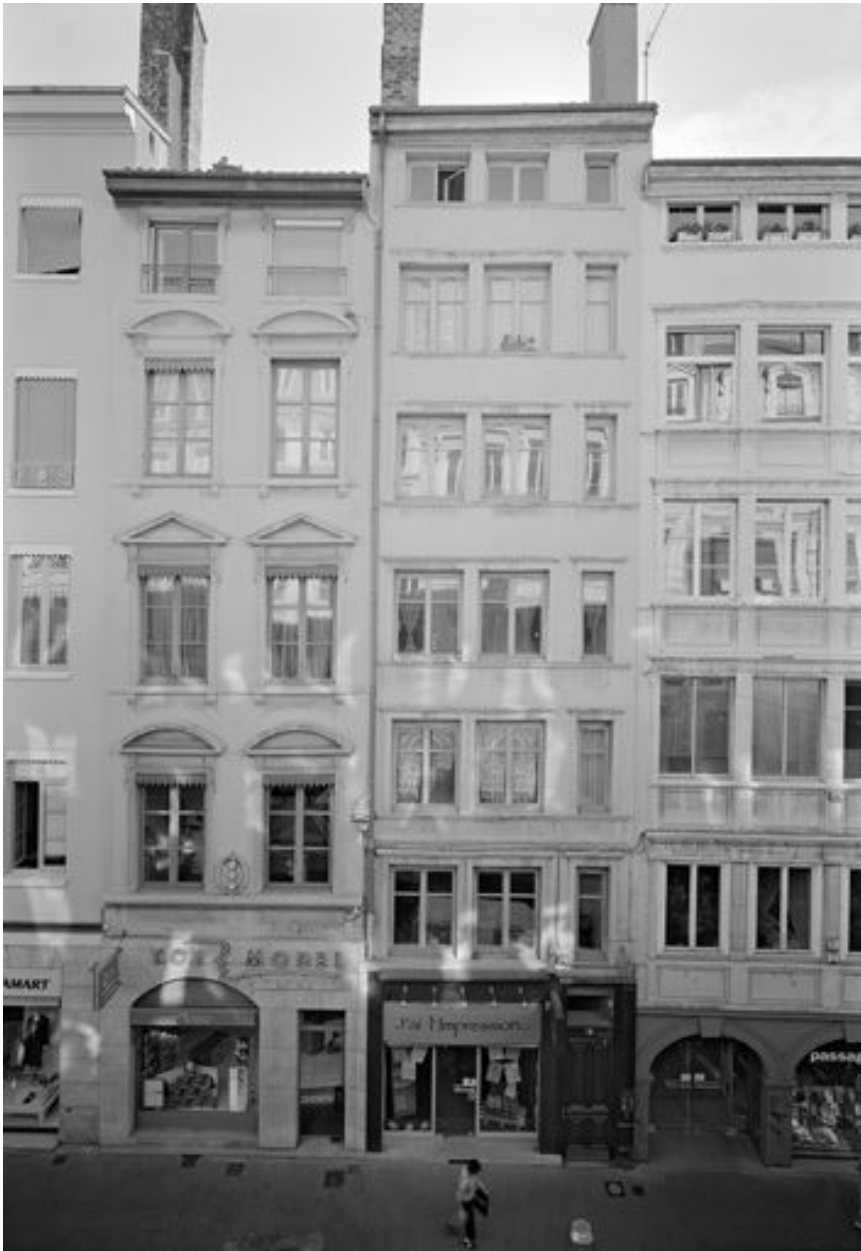
Façade, vue générale
