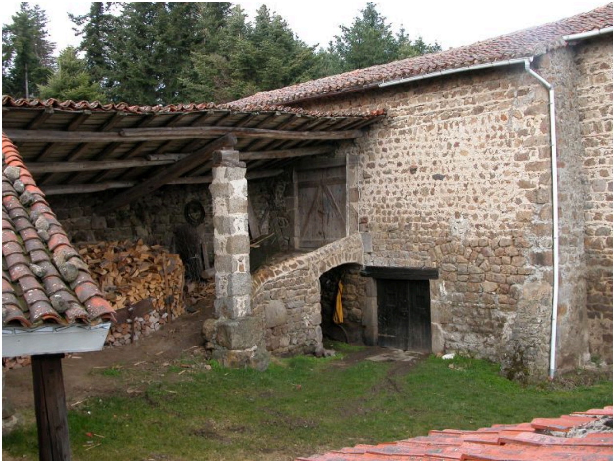
Vue d'ensemble de la grange-étable avec son montoir.
