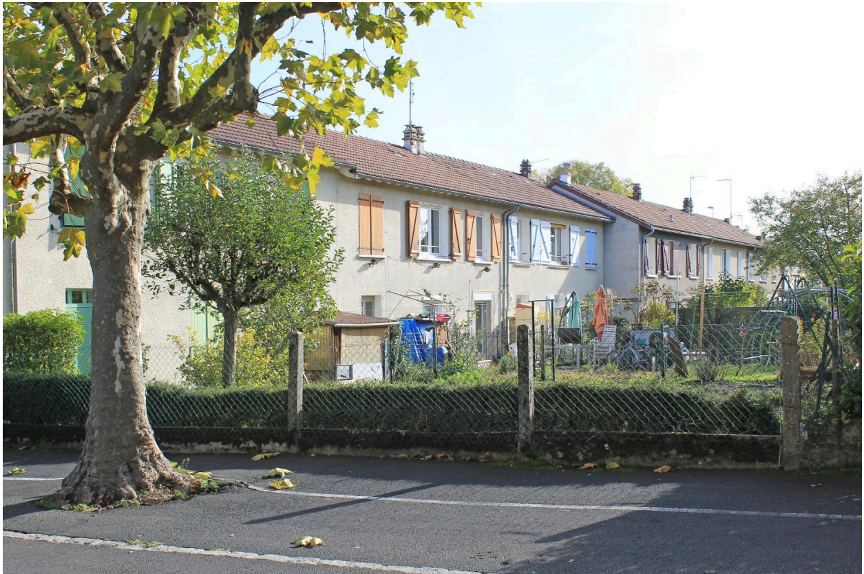
Aurillac, cité des Camisières, maisons HLR n° 28 à 36 rue de Marmesse, façades postérieures et jardins.
