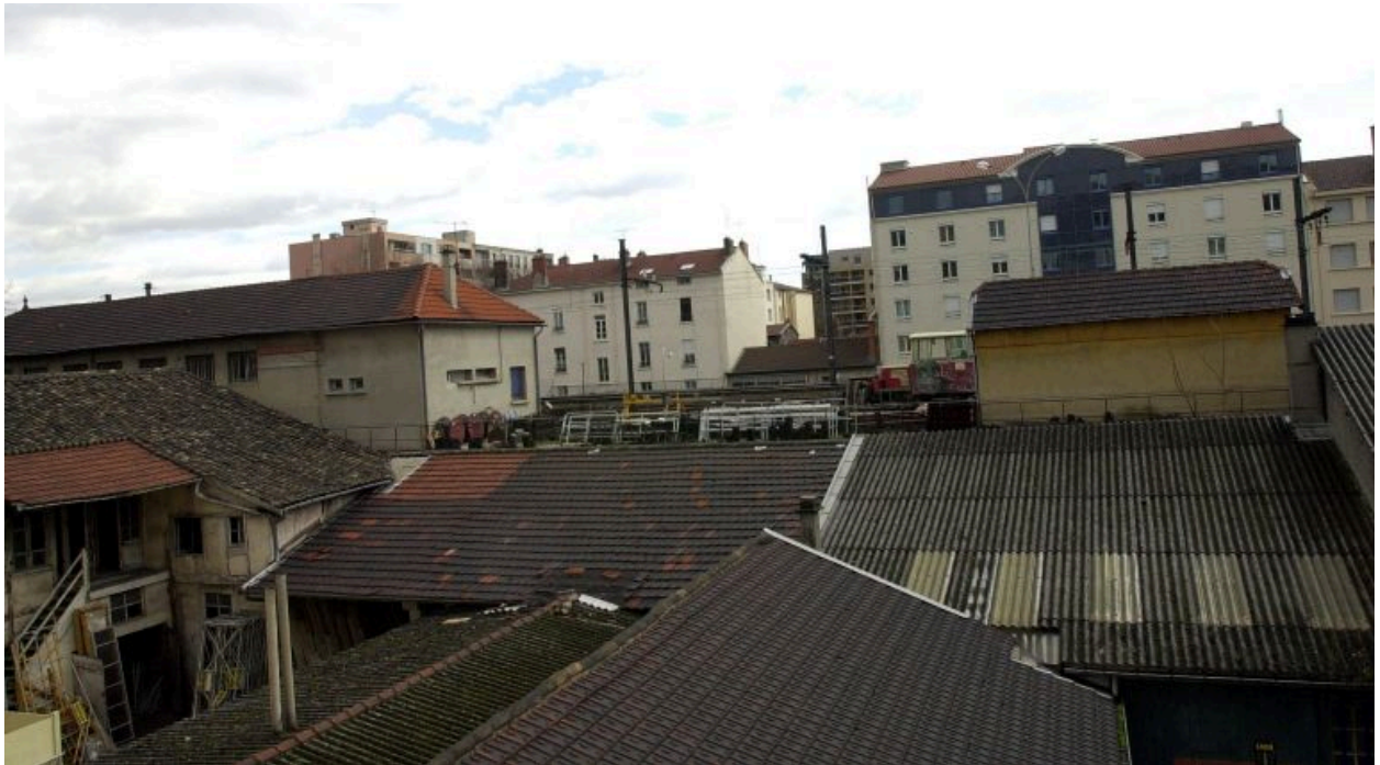
Vue des voies en terrasse derrière les édifices de la rue Denuzière
