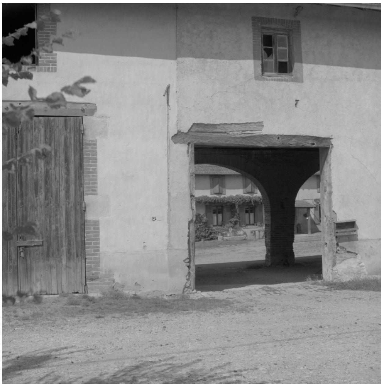
Vue du passage couvert et de la cour depuis le chemin.
