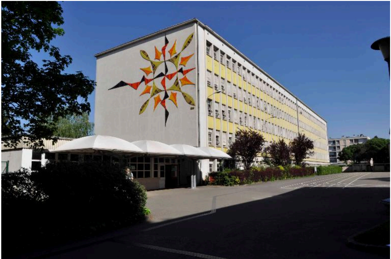
Bâtiment principal depuis le sud
