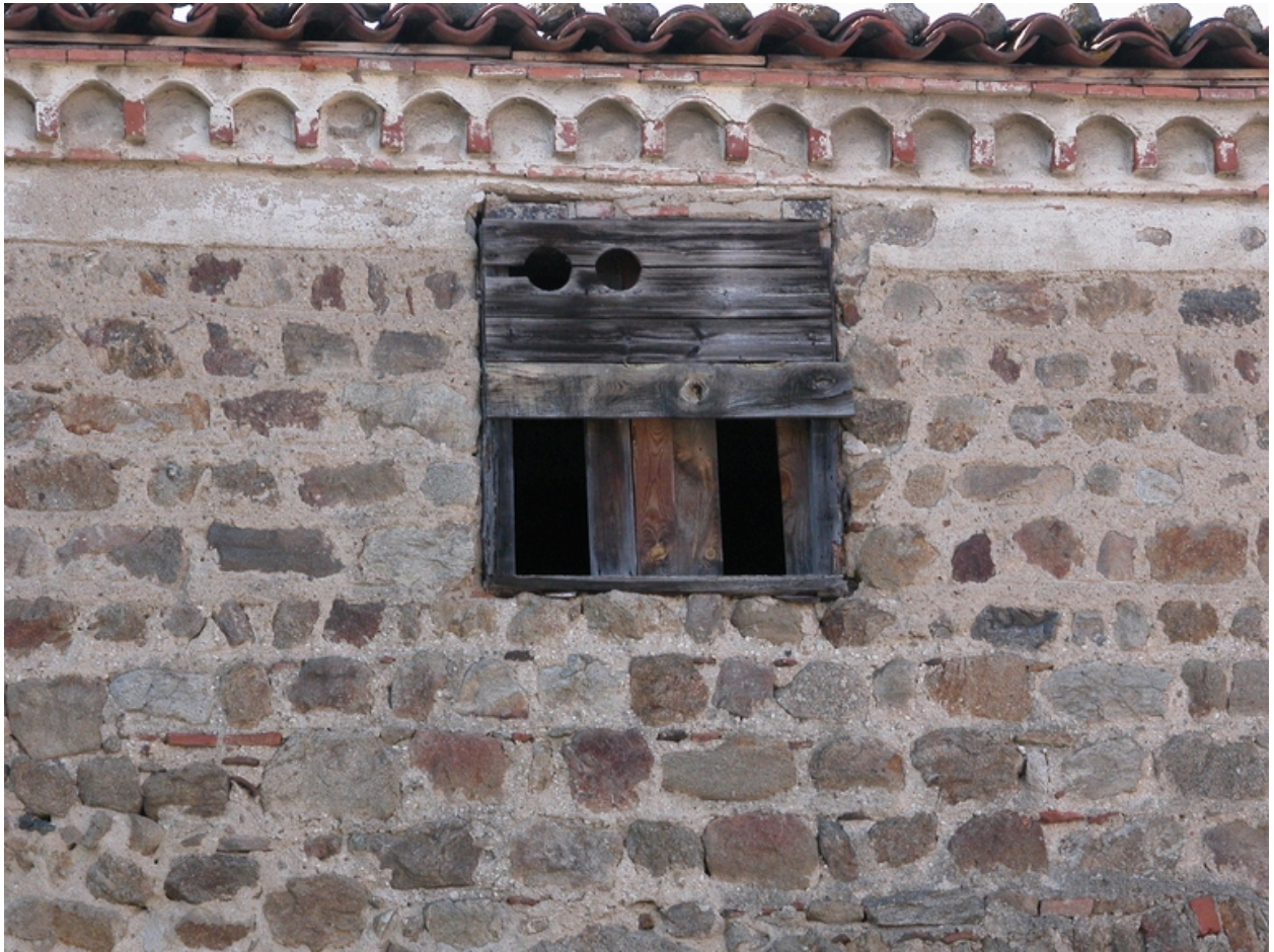
Détail de l'ouverture du pigeonier du logis oriental.
