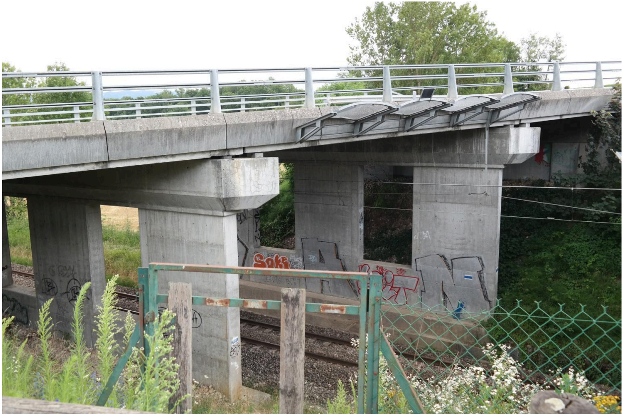
Nouveau pont des Anonciades, vue depuis l'ancien pont
