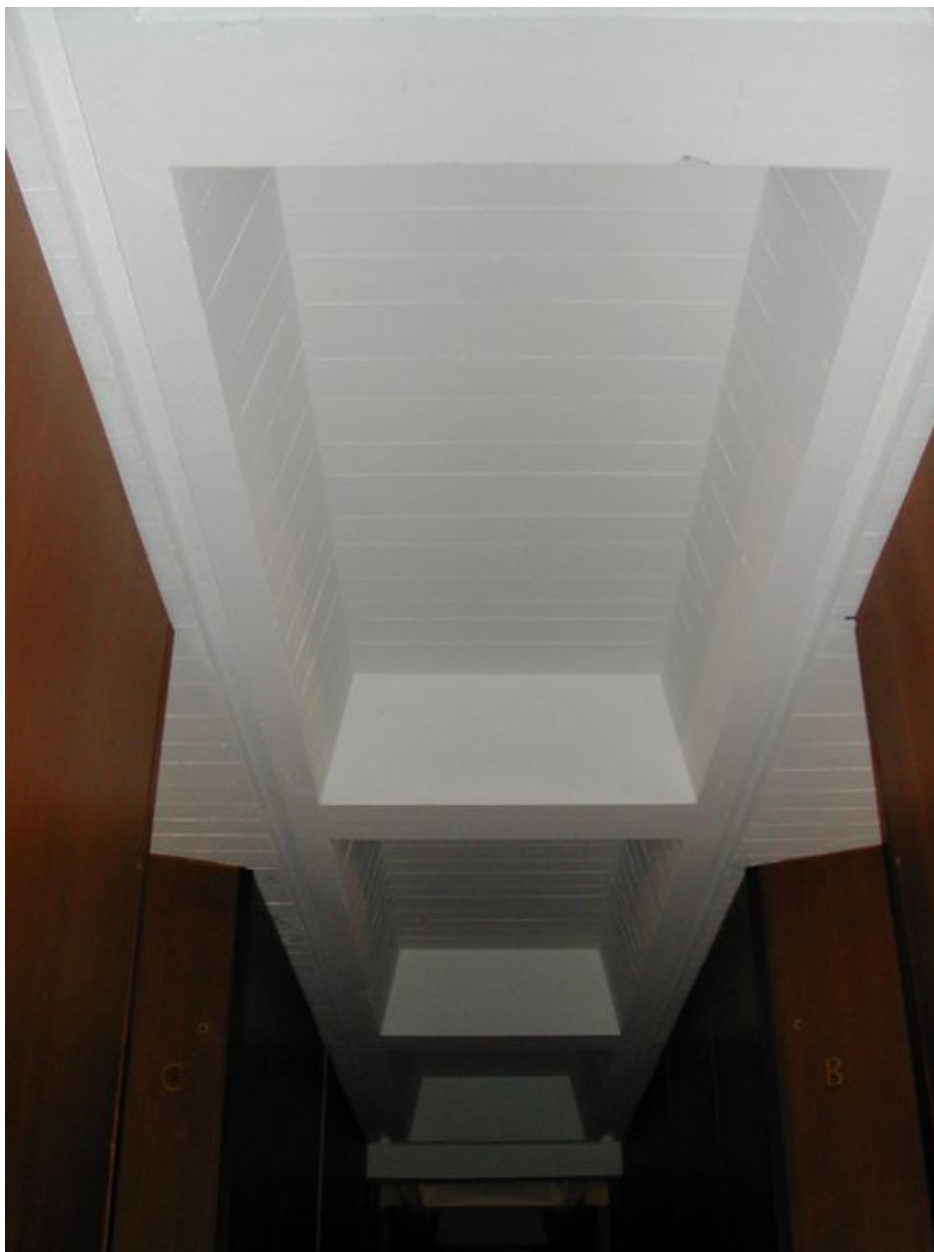
Couloir de distribution des appartements. Détail du plafond
