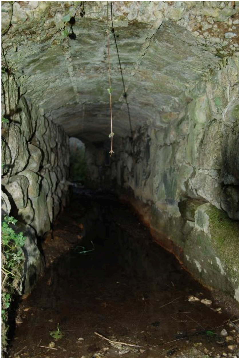
Conduit d'échappée de l'eau du moulin aval, entrée de l'extrémité avale.
