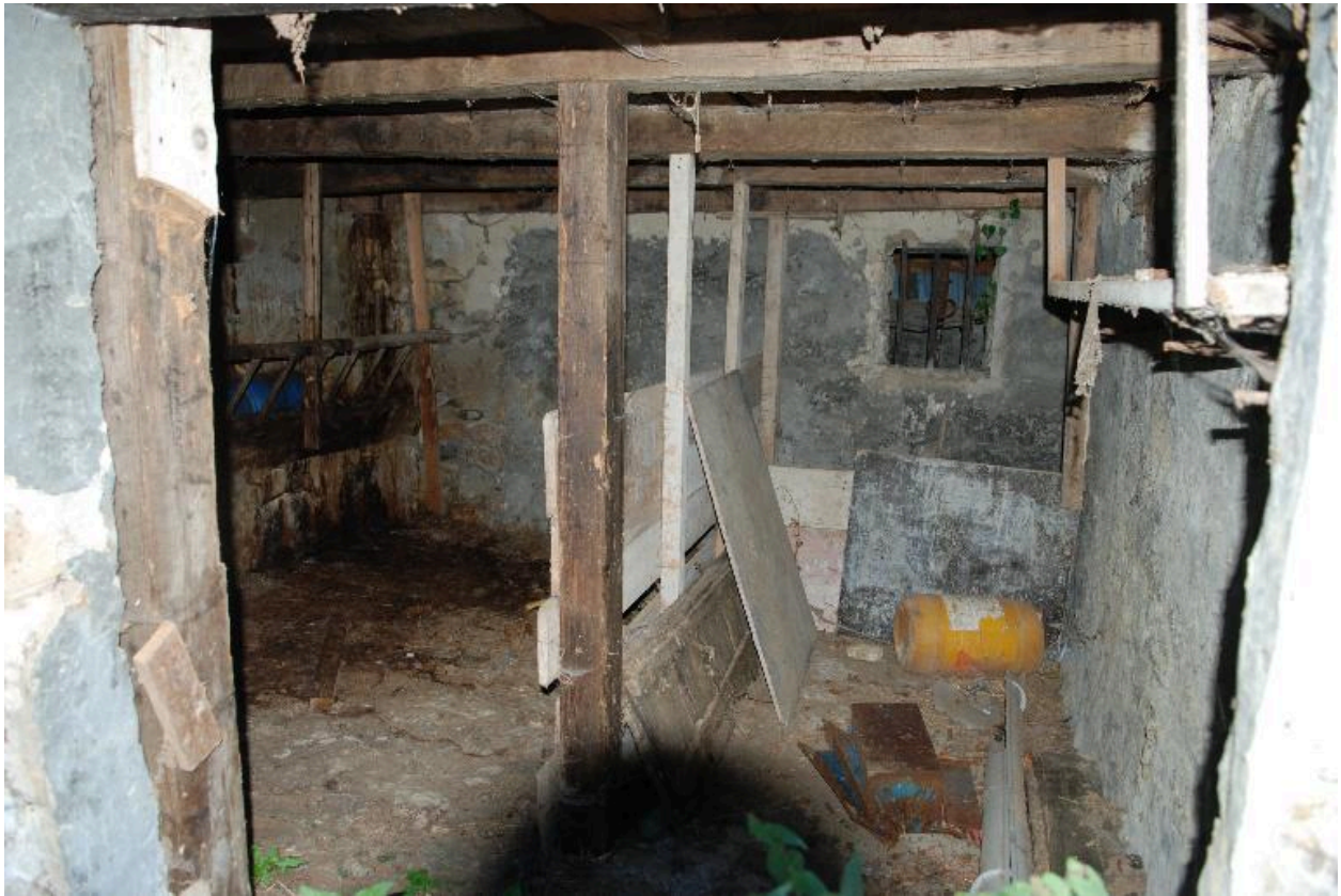
Vue intérieure de l'étable.
