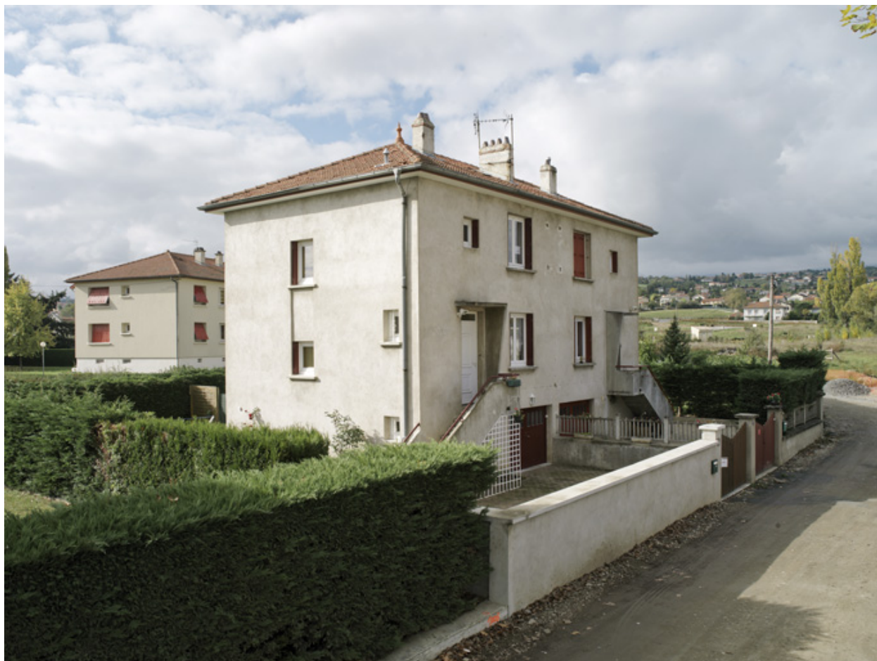
Vue d'ensemble de trois-quarts nord-est du bâtiment n° 8.
