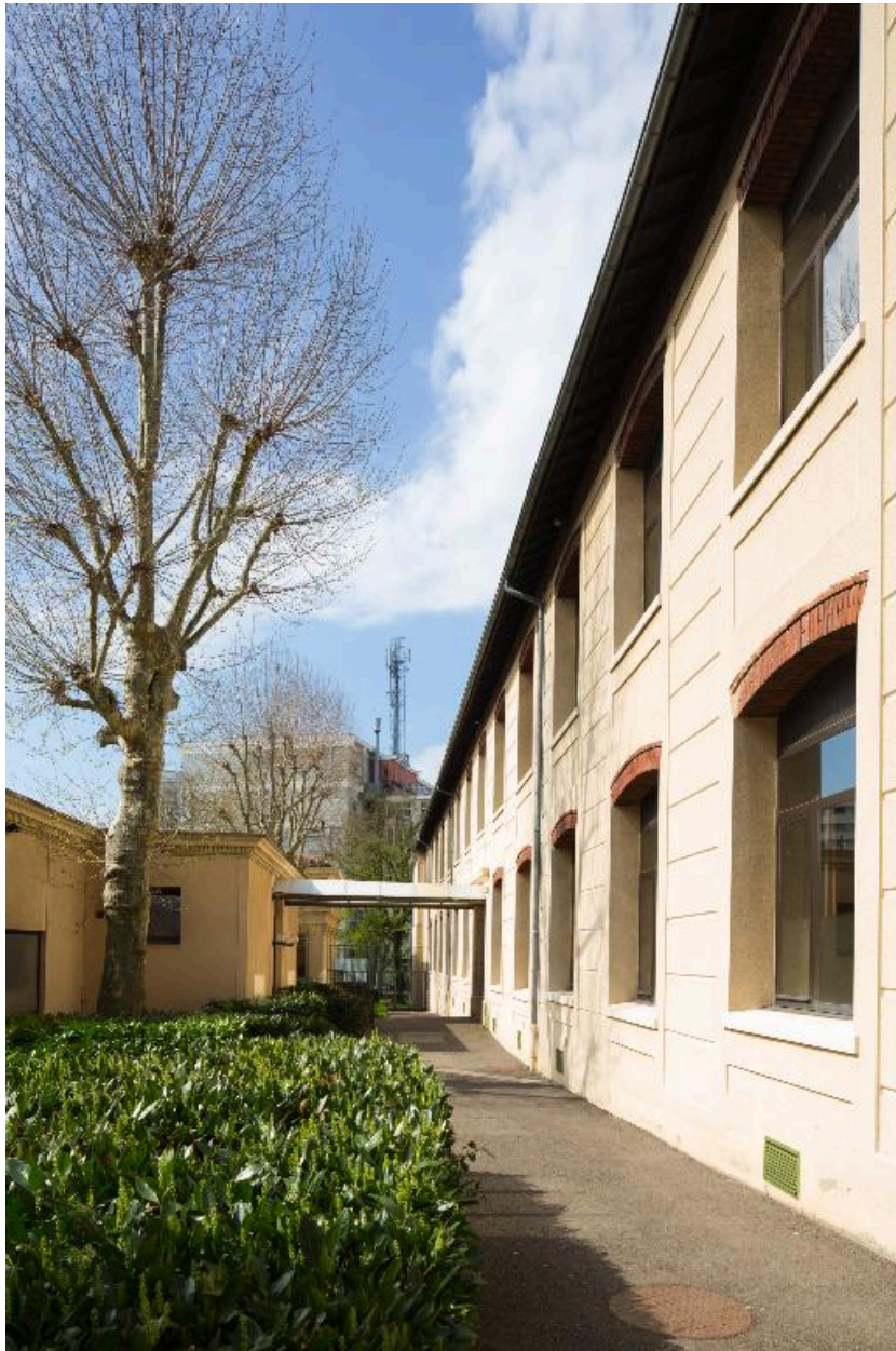
Bâtiment A et accès au bâtiment E
